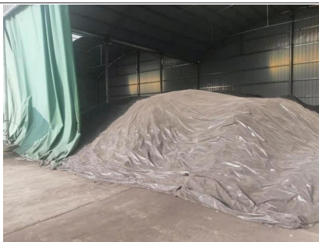
储煤库地面硬化
