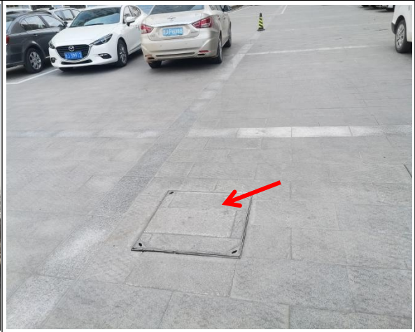
医技楼化粪池
