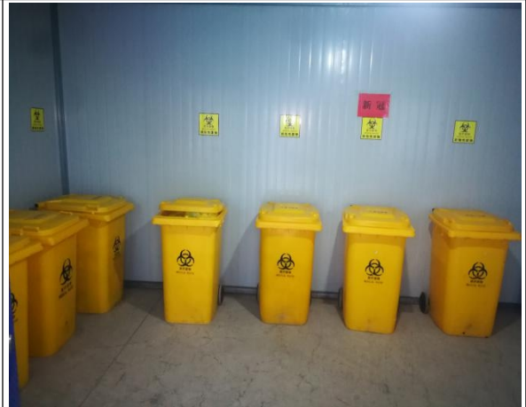
医疗废物暂存间（内部）
