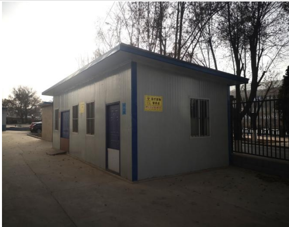
医疗废物暂存间（外部）
